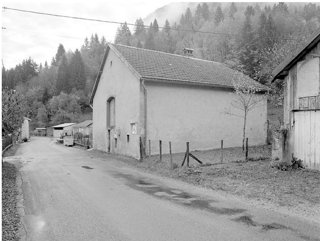
Face nord et façade postérieure.
