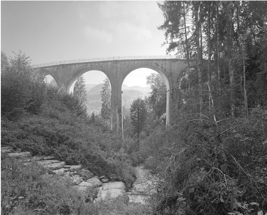
Le viaduc depuis le ruisseau du Nans.
