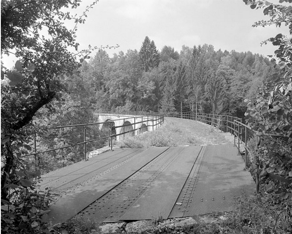
Tablier du viaduc.
