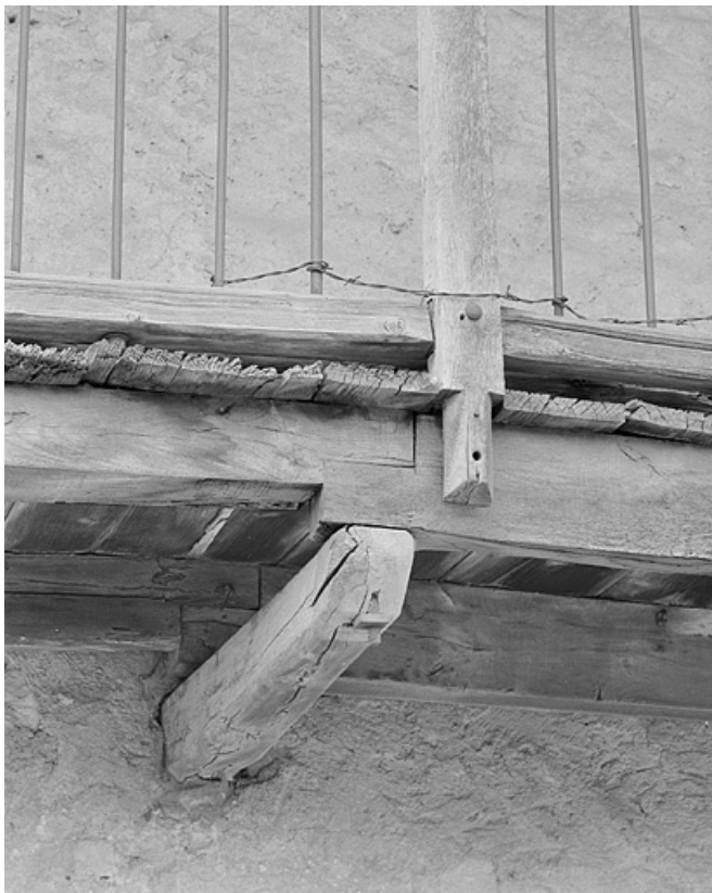
Détail du balcon de l'étage.
