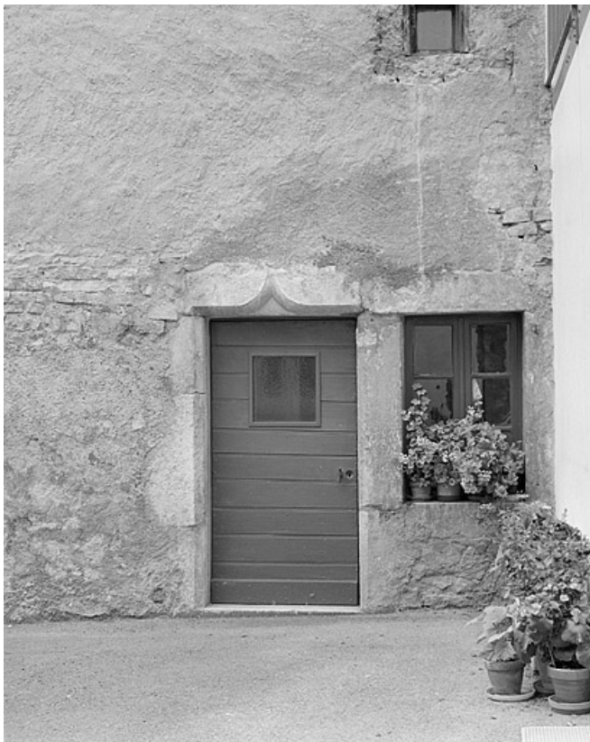
Porte d'accès avec linteau en accolade.
