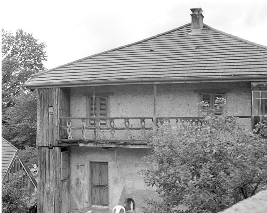
Balcon en galerie sur la façade antérieure.
