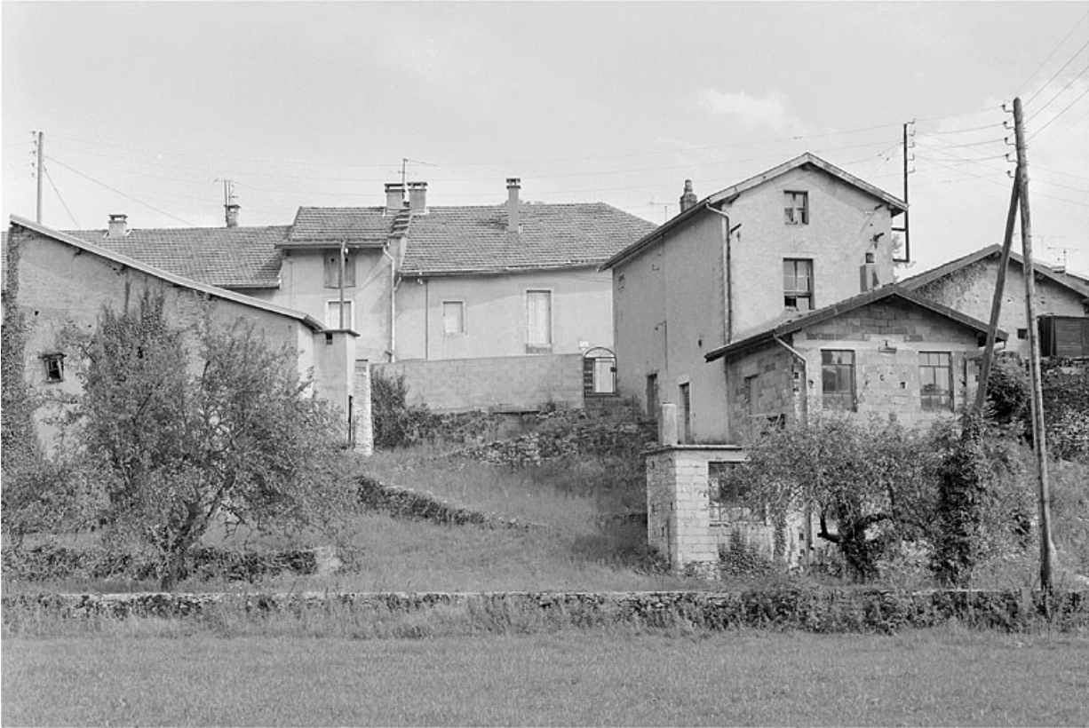
Vue postérieure de l'atelier de pipes.
