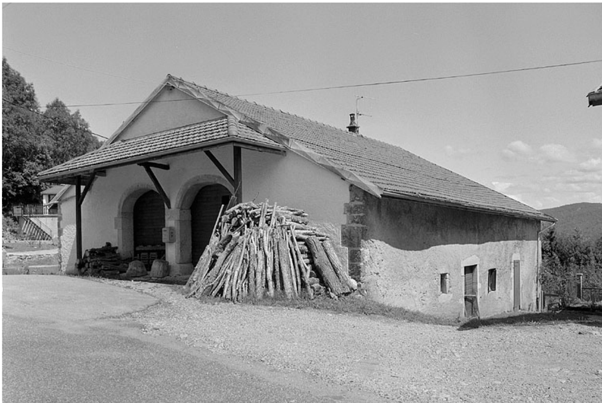
Façade postérieure et face sud.
