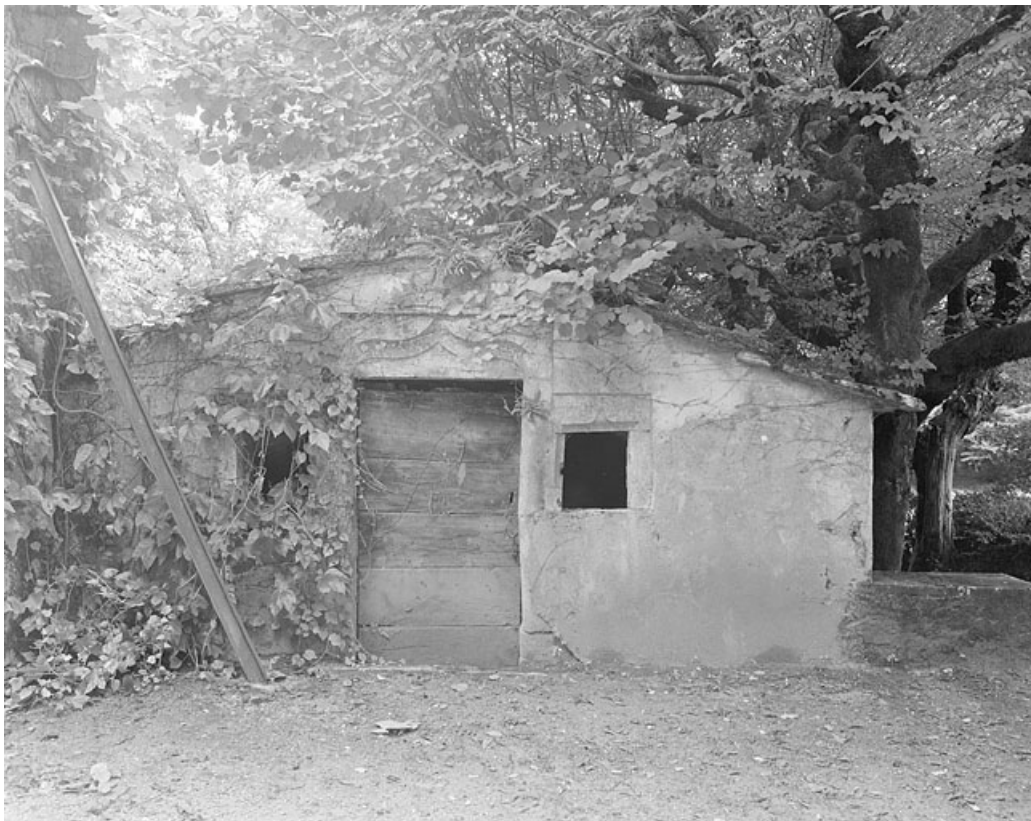
Façade antérieure du fournil.
