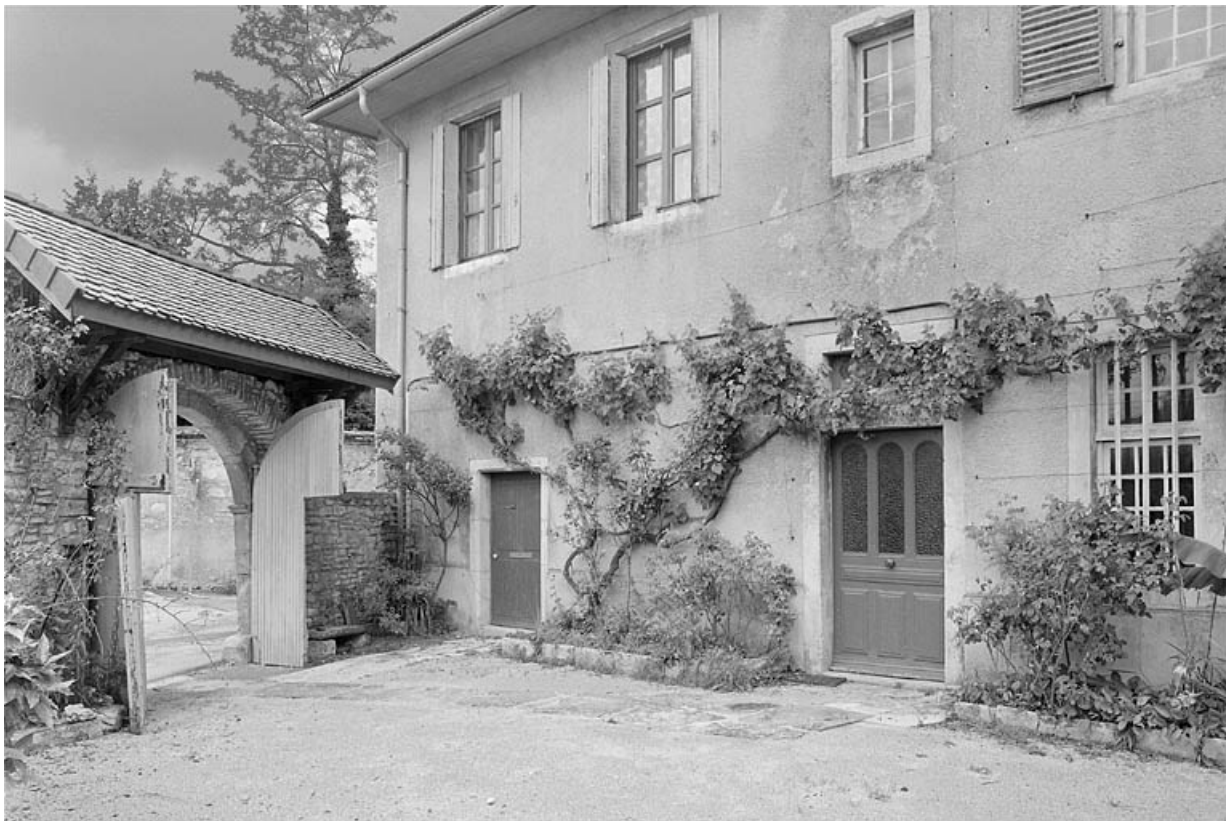
Façade antérieure, partie gauche.
