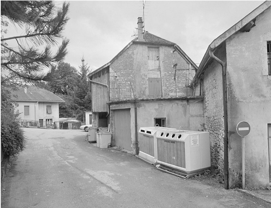
Face droite de l'ancienne fromagerie.
