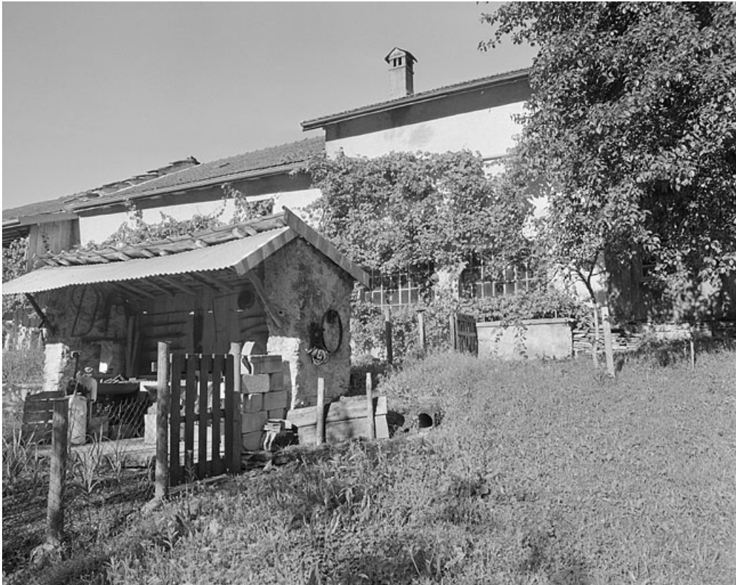
Façade postérieure de l'atelier.
