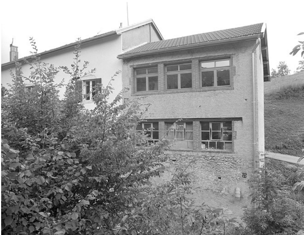
L'atelier de tournerie accolé à la ferme.
