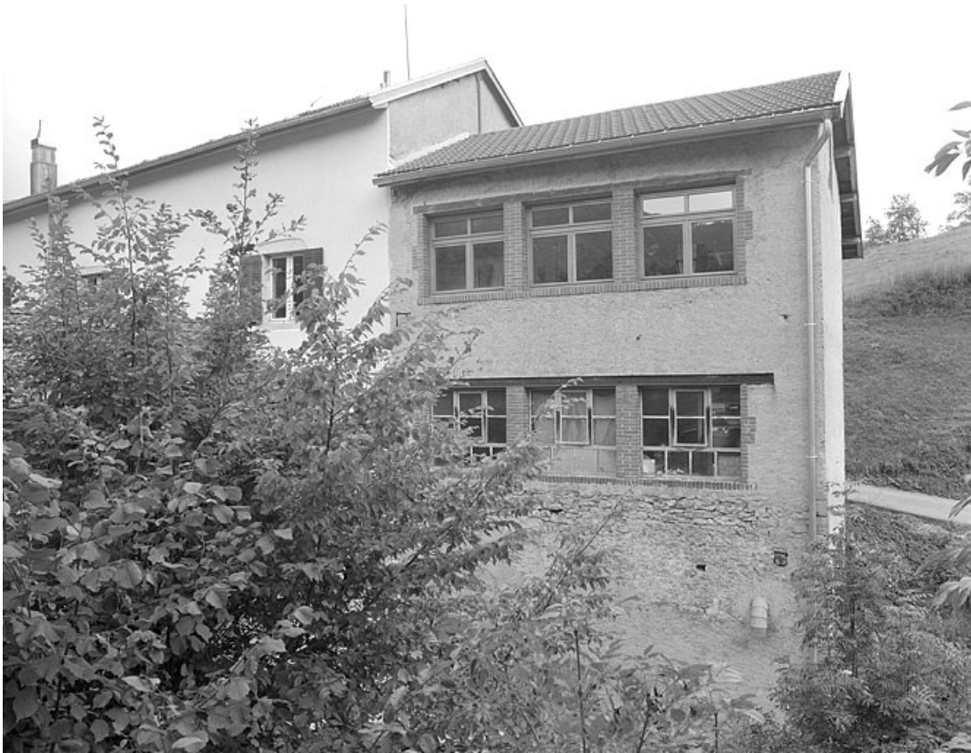
L'atelier de tournerie accolé à la ferme.
