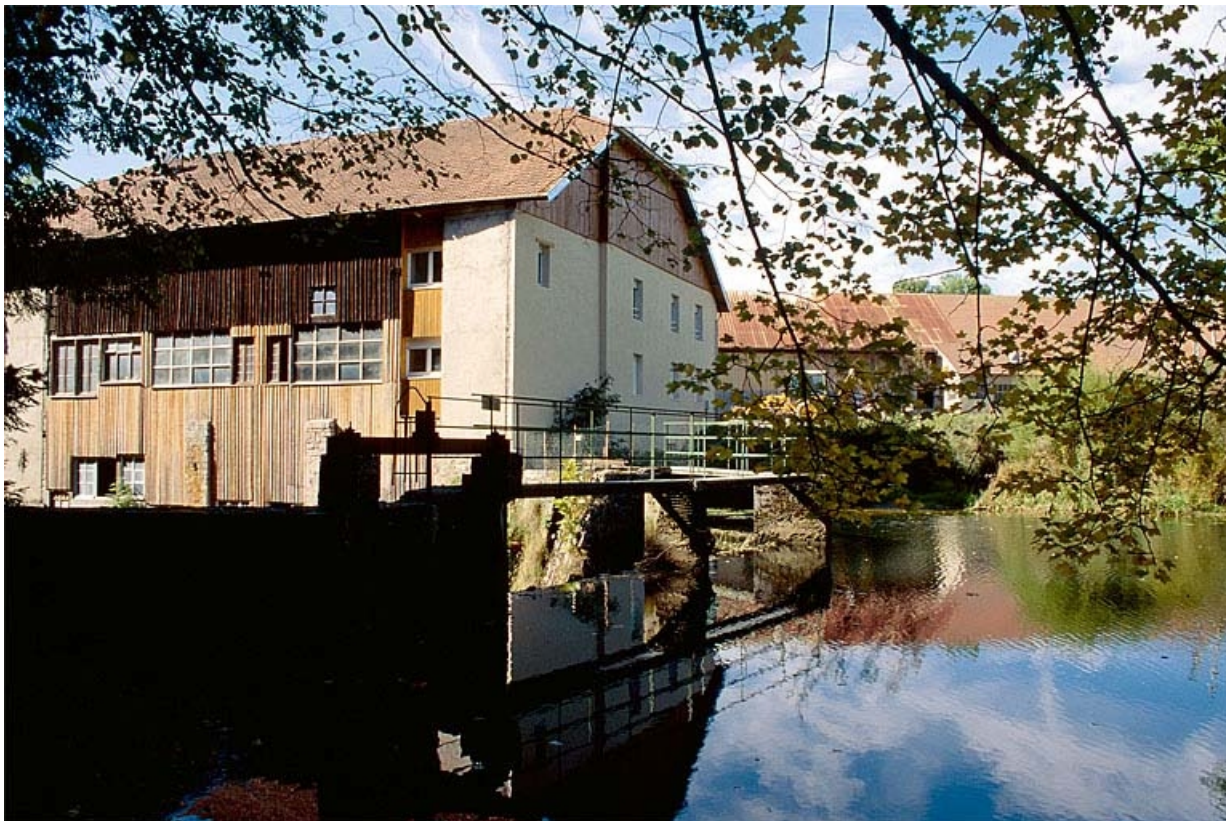
Au premier plan, bassin de retenue.
