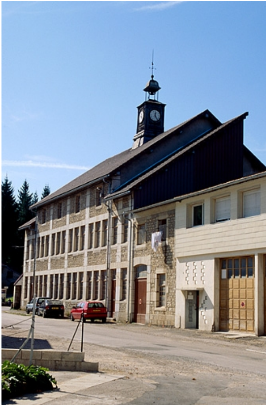
Façade antérieure de l'atelier de fabrication.
