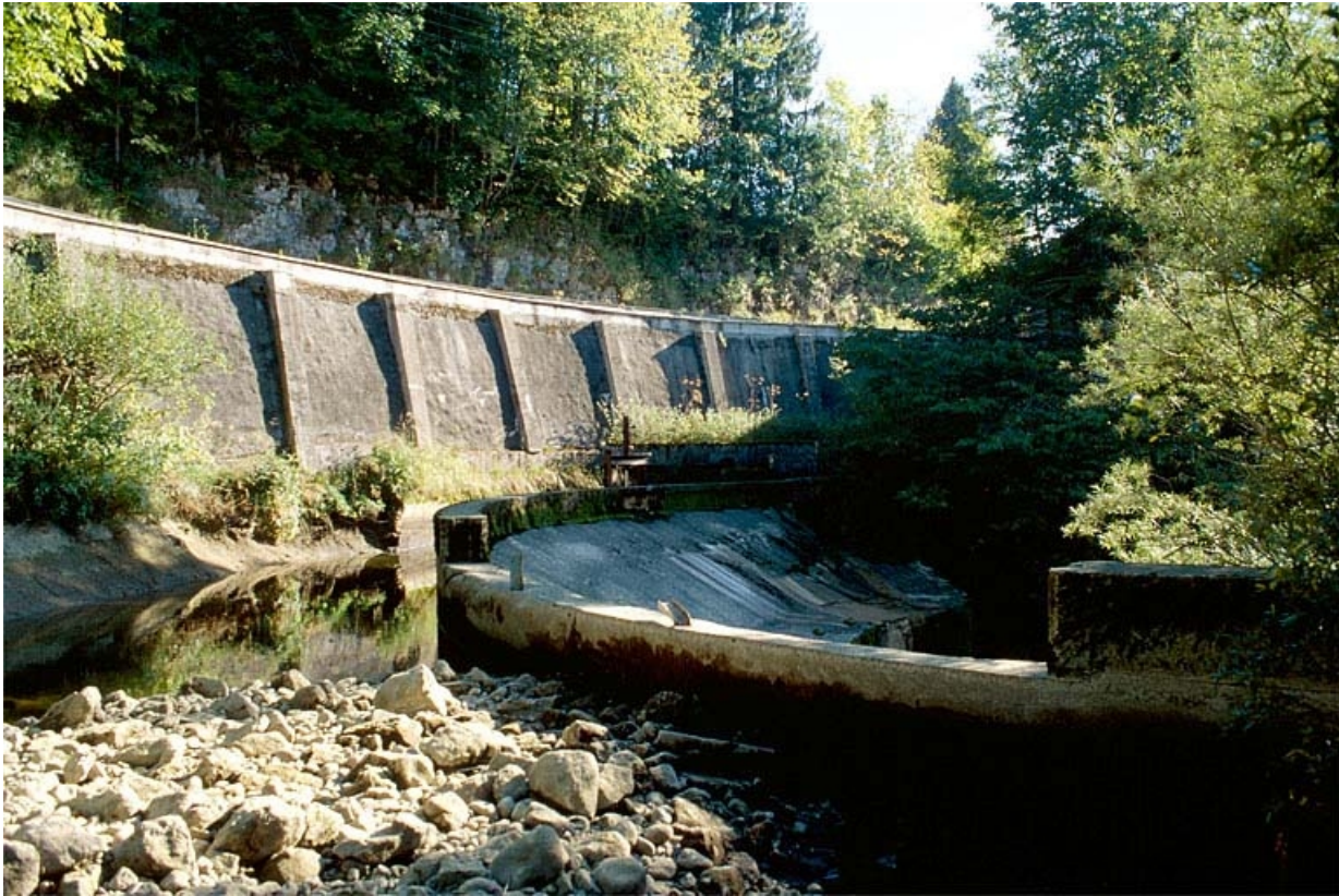
Canal d'amenée et déversoir du barrage.
