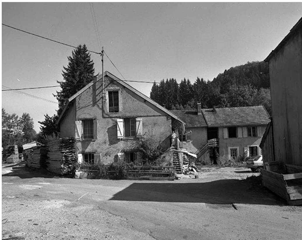
Logements d'ouvriers depuis l'ouest.
