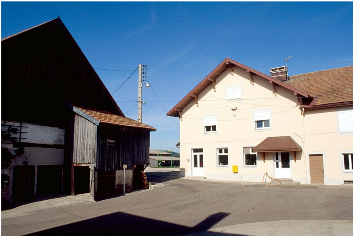
Pignon sud-est de la fromagerie.
