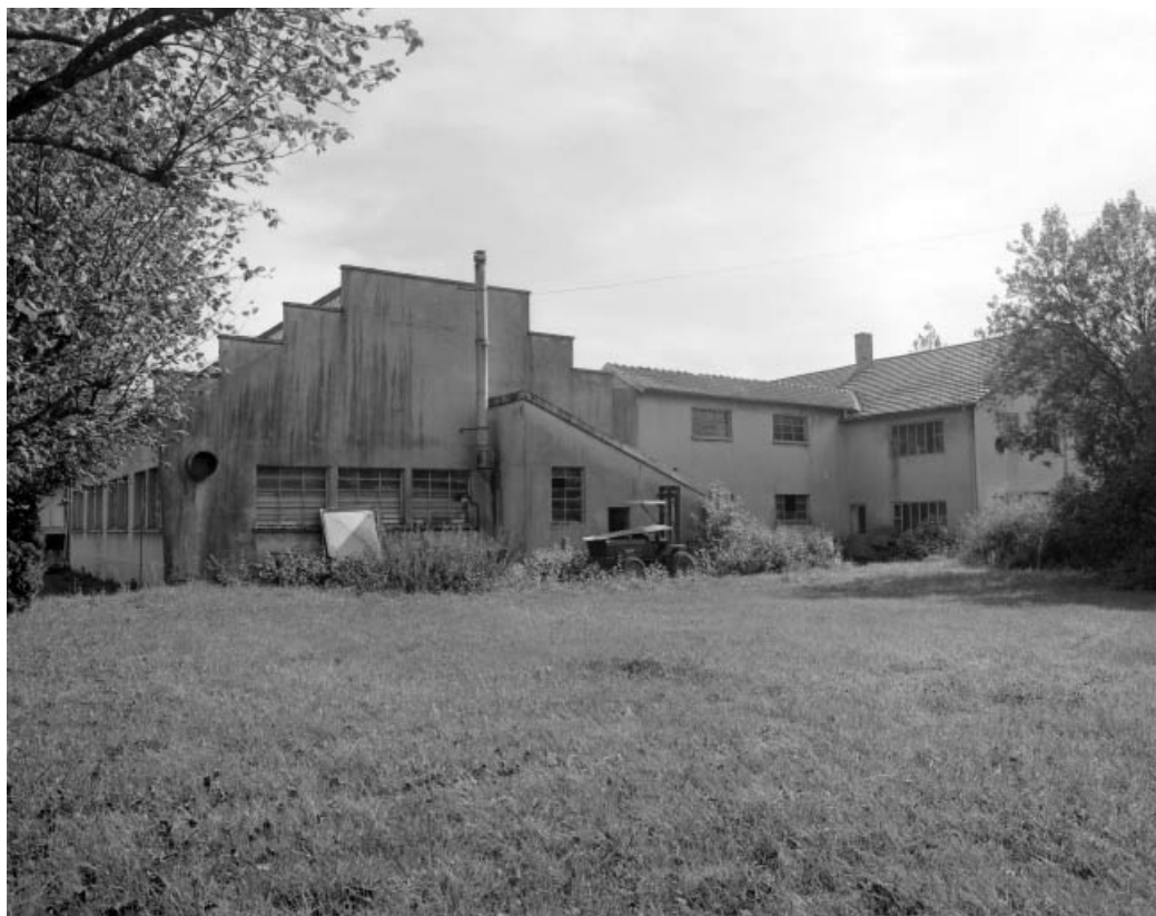
Façades postérieures des ateliers de fabrication.
