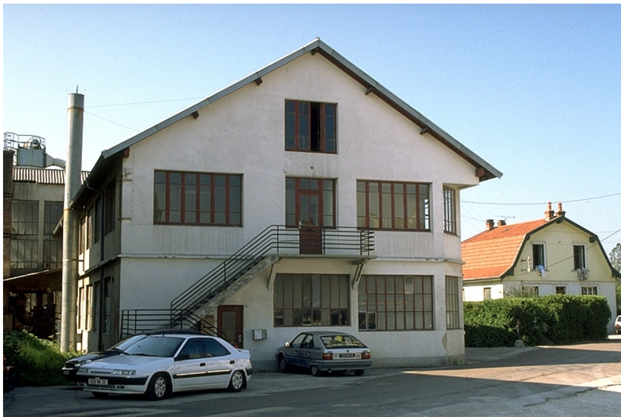
Façade antérieure (bureau).
