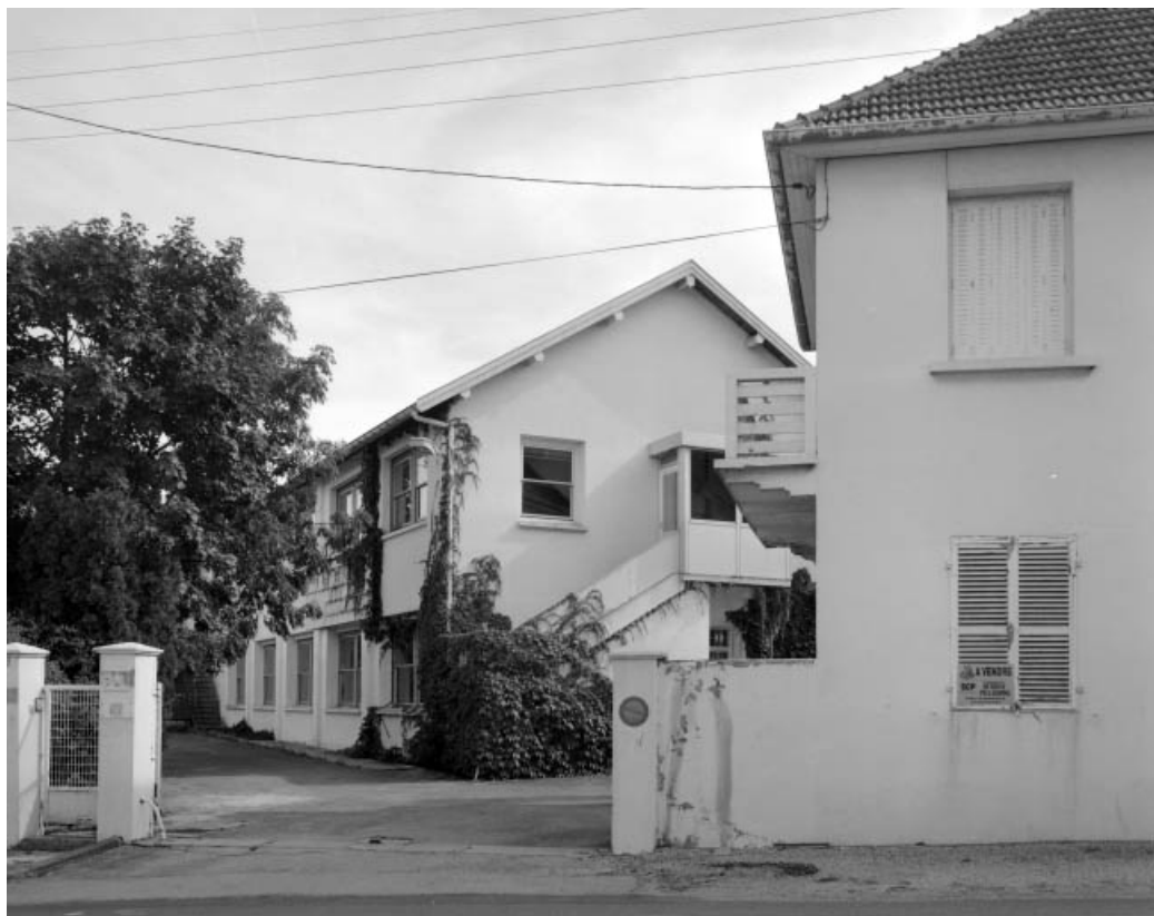
Entrée de l'usine, bureau et réfectoire.
