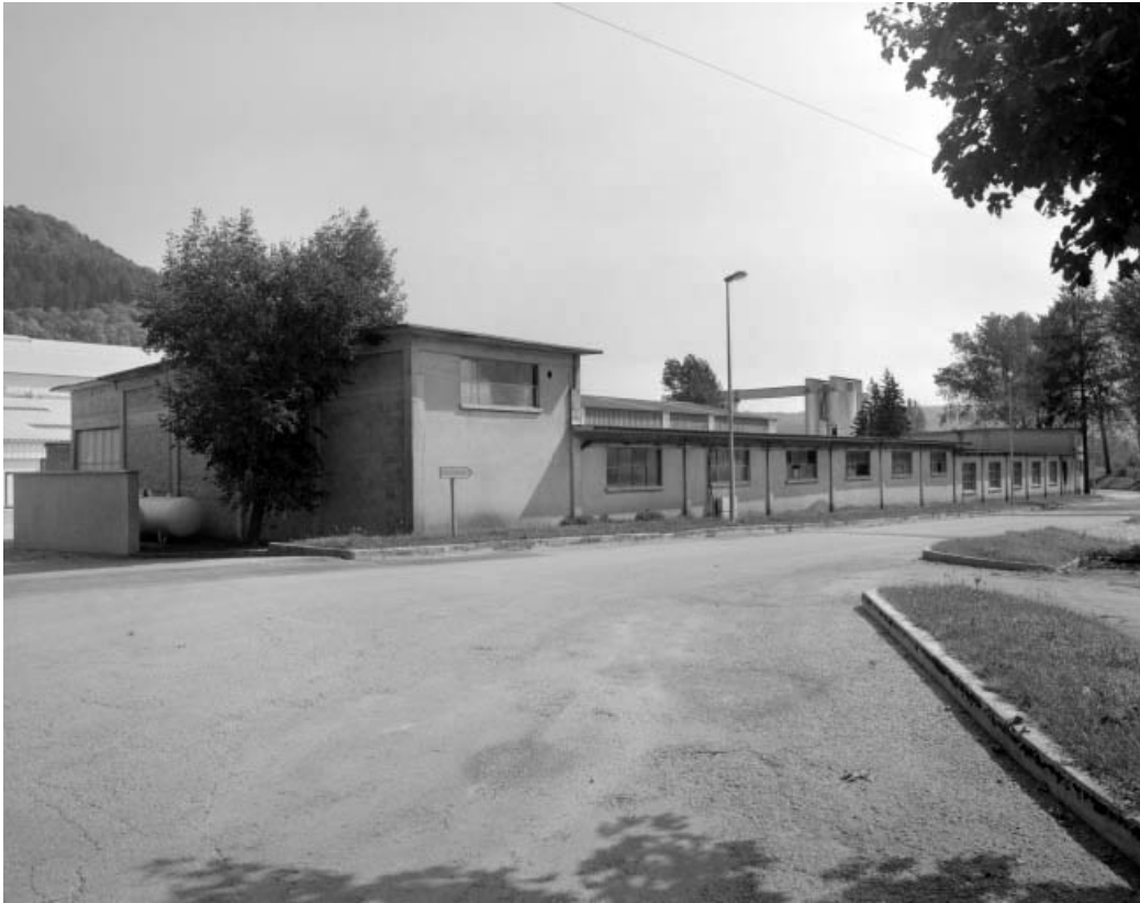
Façade ouest de l'atelier de réparation.
