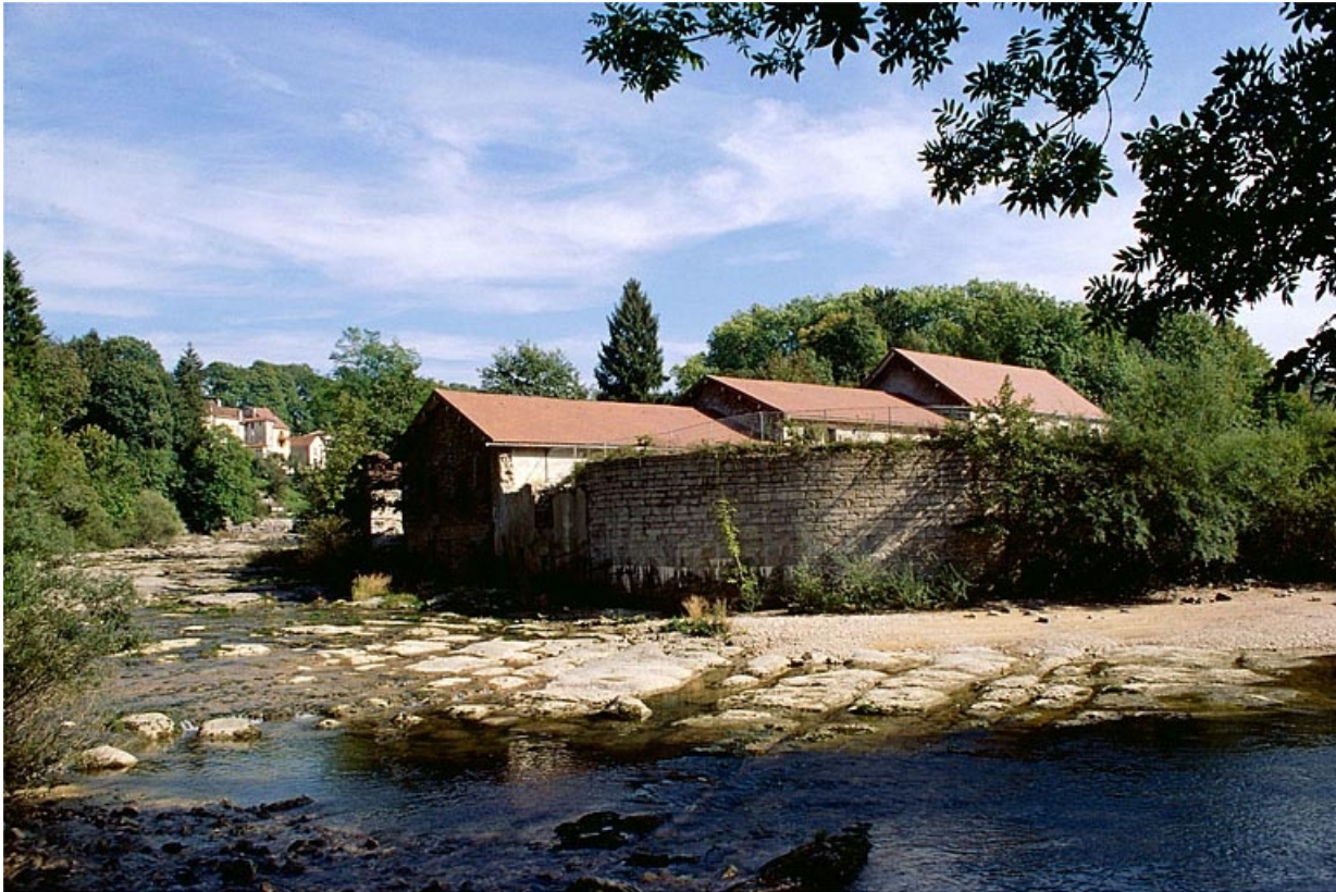
Extrémité nord depuis la rive droite.
