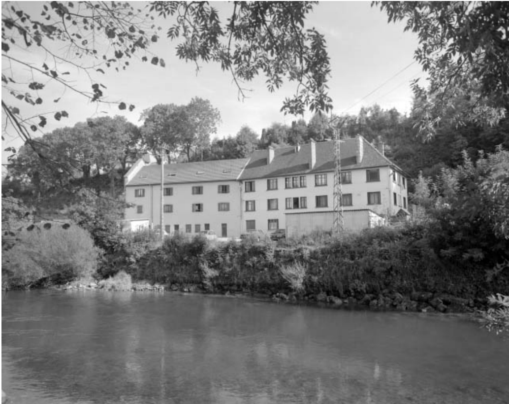
Logements ouvriers depuis l'ouest.
