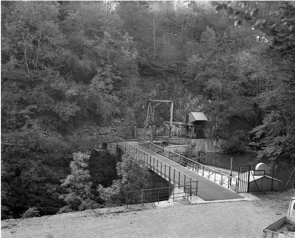
Vue d'ensemble de la prise d'eau.
