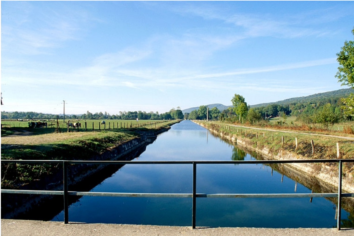
Le canal d'amenée depuis la prise d'eau.
