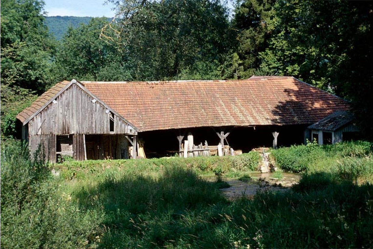
Atelier de fabrication depuis l'est.
