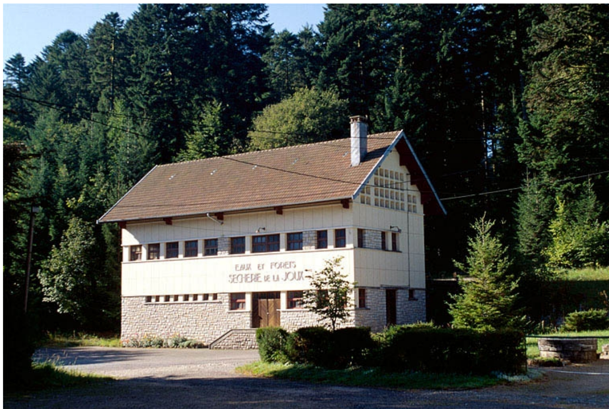
Vue d'ensemble de la sécherie résineuse.
