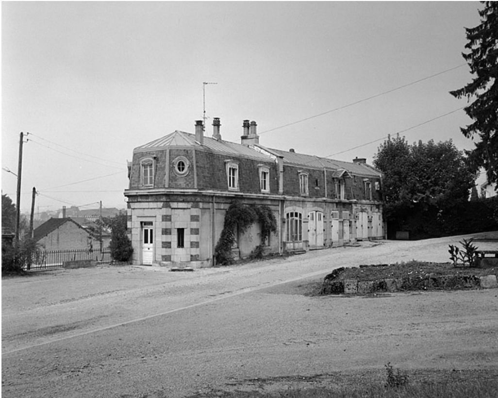
Bureau, logement et chai est.
