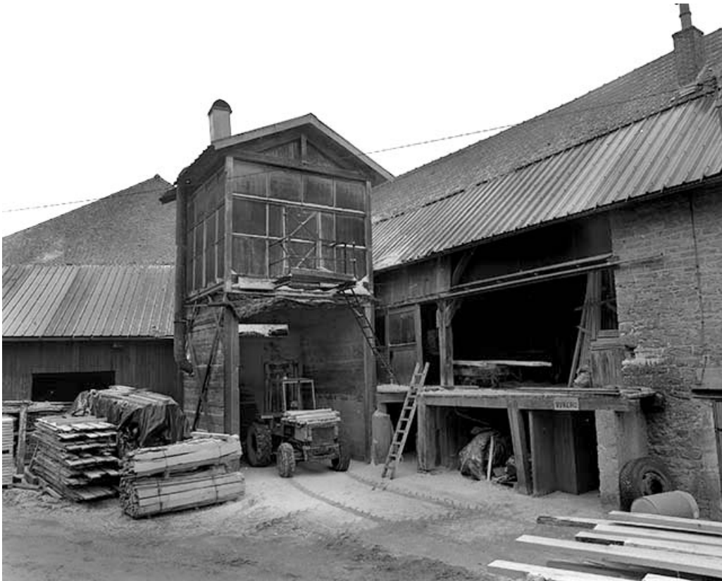
Silo à sciure et atelier de fabrication.
