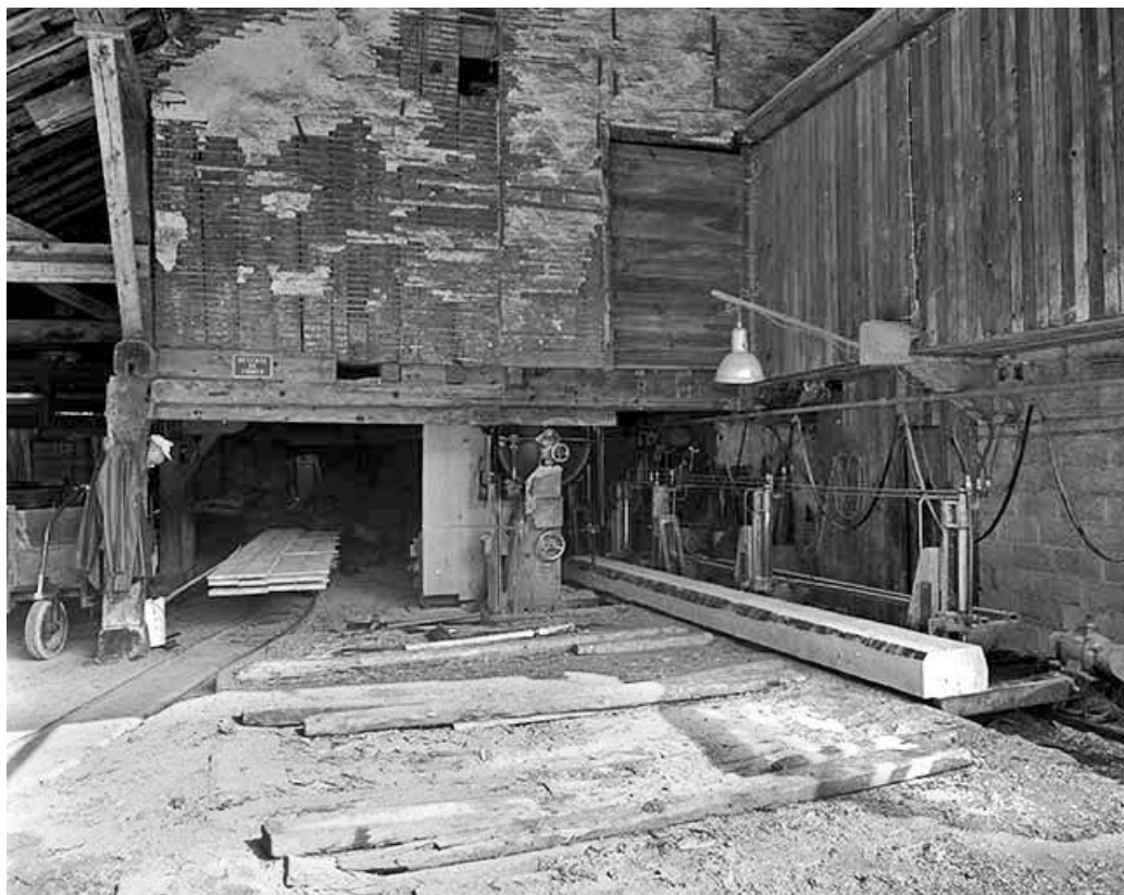
Intérieur de l'atelier de sciage.
