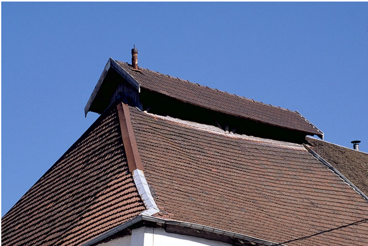
Atelier de fabrication : détail de la toiture.
