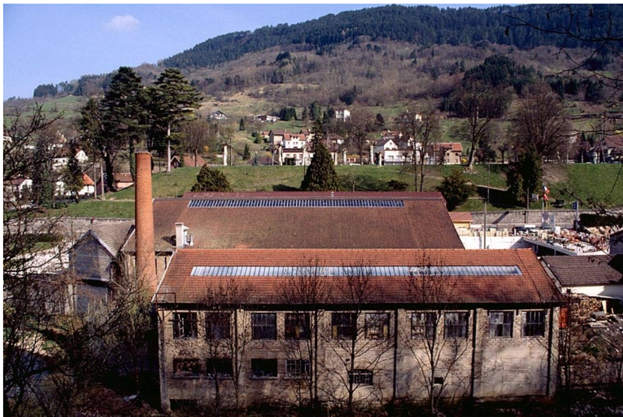
Façade postérieure de l'atelier de mécanique générale.
