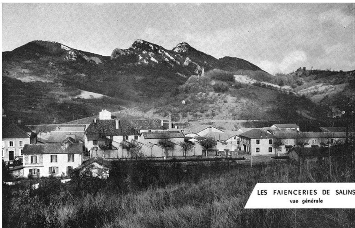
Les Faïenceries de Salins. Vue générale.
