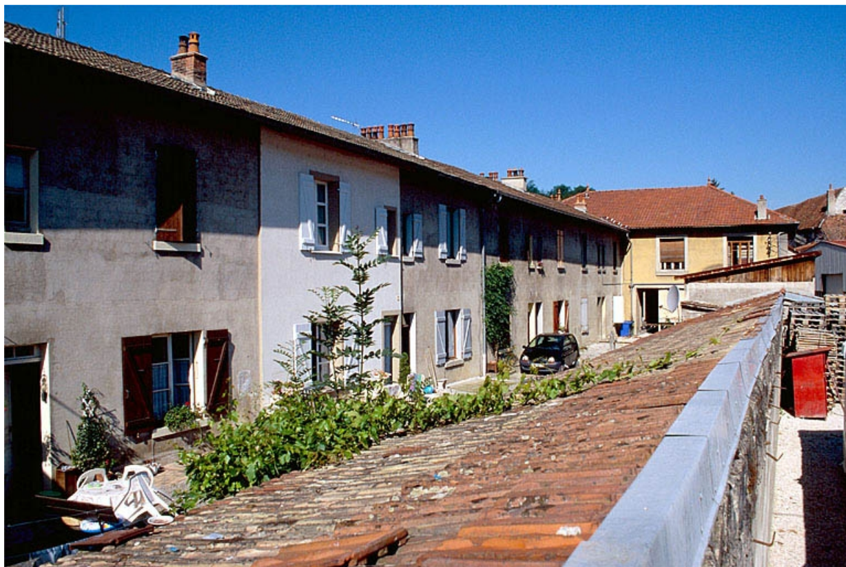
Façade postérieure des logements ouvriers.
