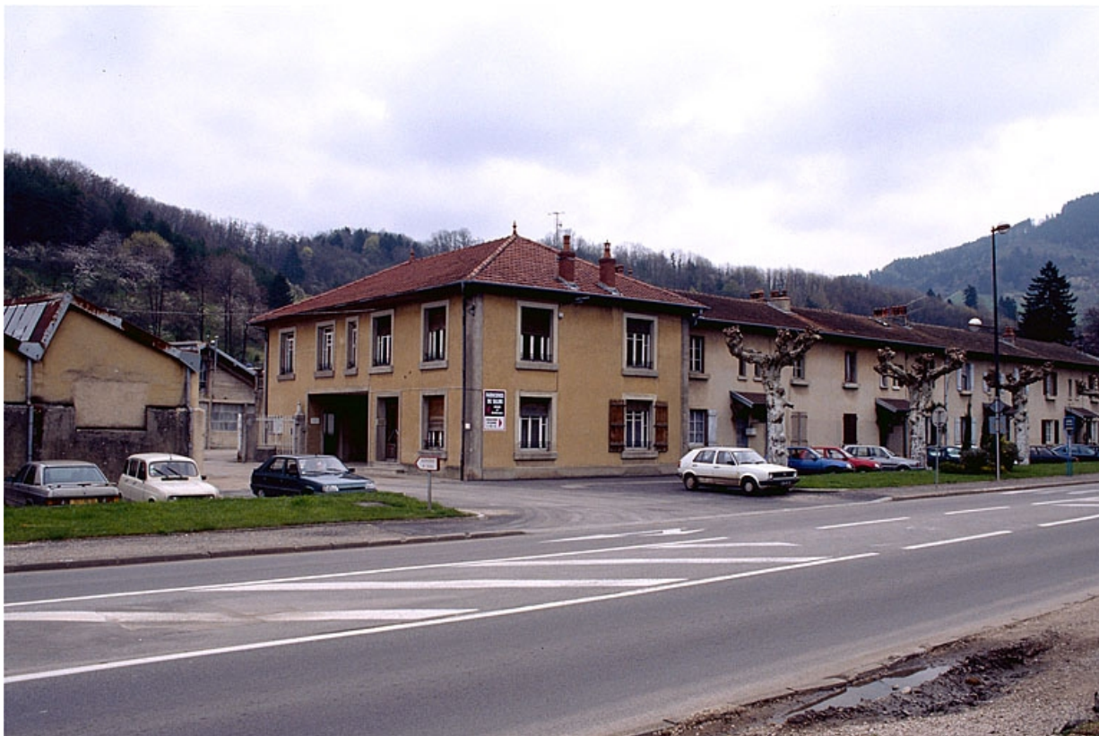
Entrée de l'usine depuis l'avenue.
