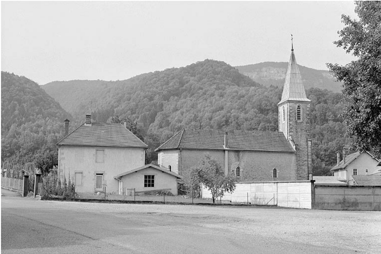
Vue de situation depuis le nord-est.
