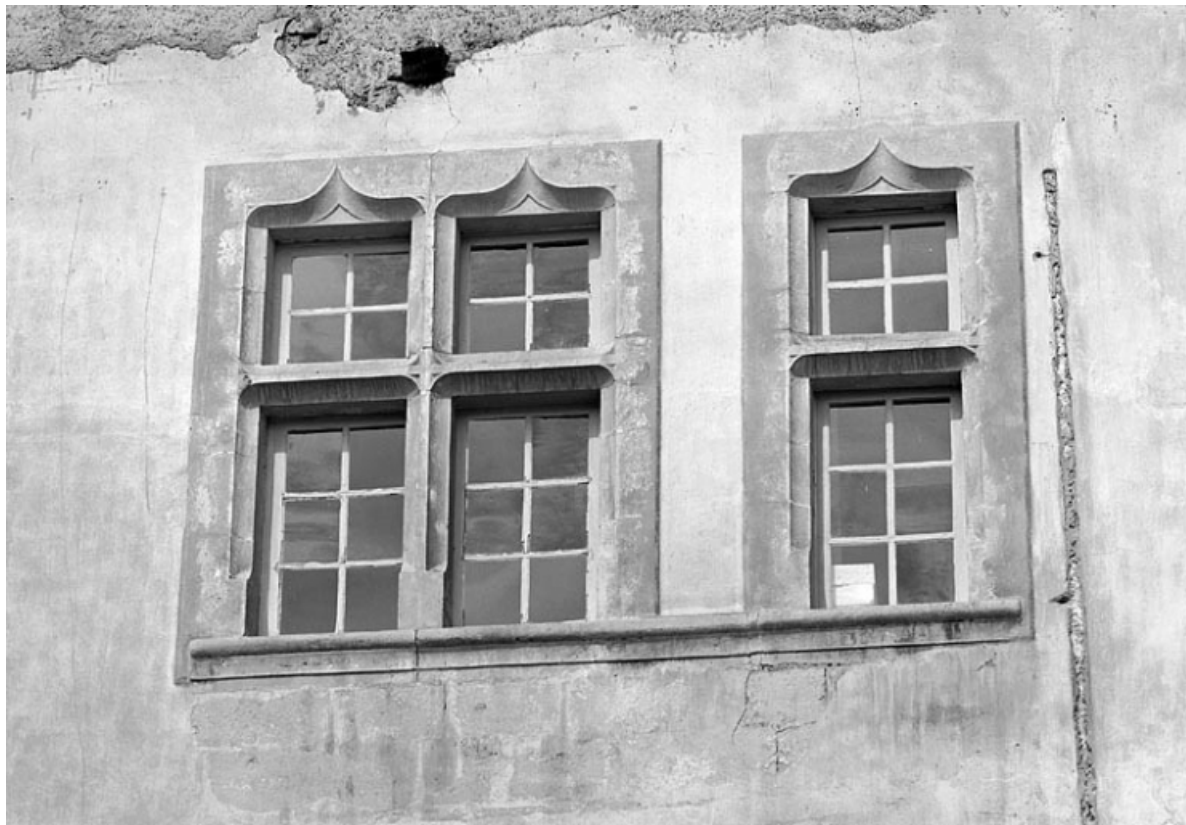
Fenêtres de l'étage de la face est.
