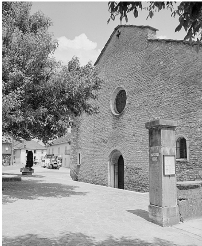
Façade ouest de l'église.
