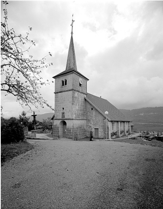
Façade antérieure et face droite.
