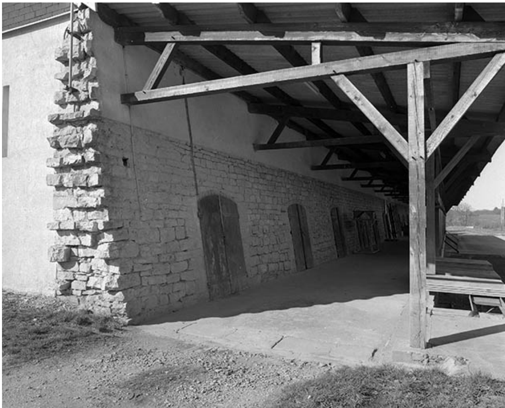
Mur nord du magasin industriel.
