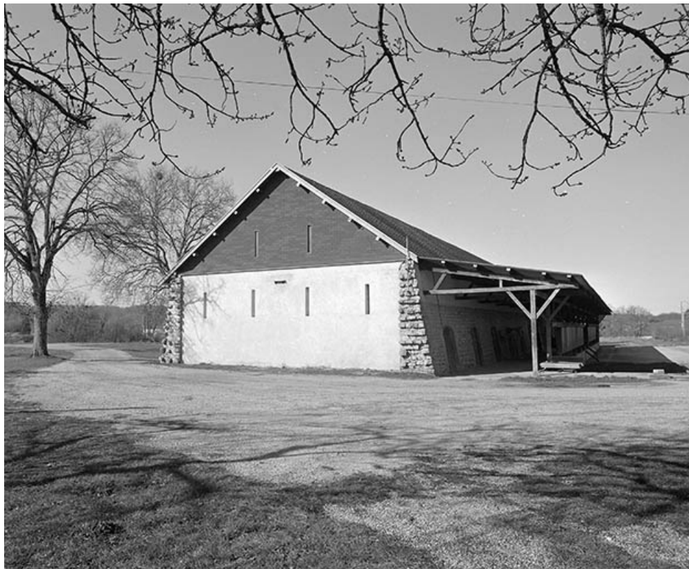
Extrémité orientale du magasin industriel.
