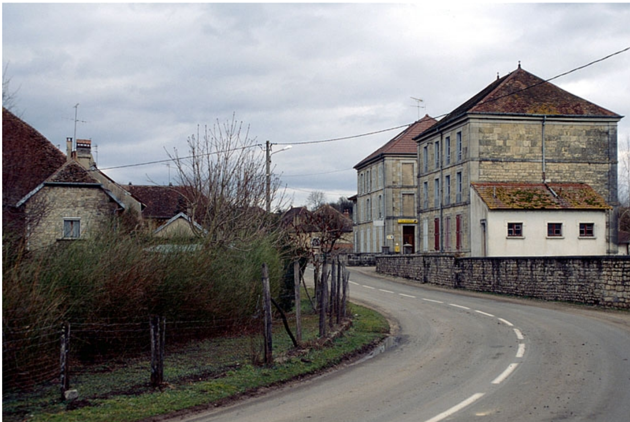
Bureaux et logements depuis la route.
