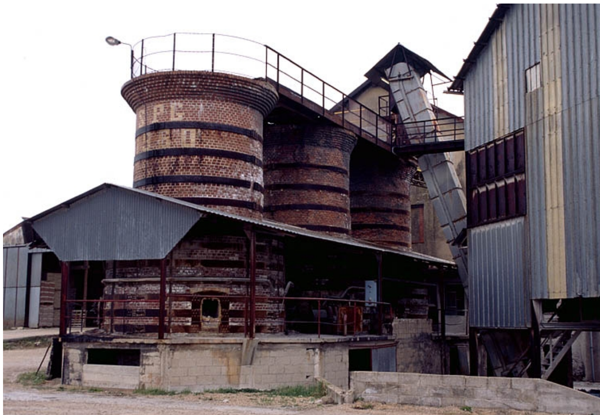
Les fours à surcuit depuis le sud.
