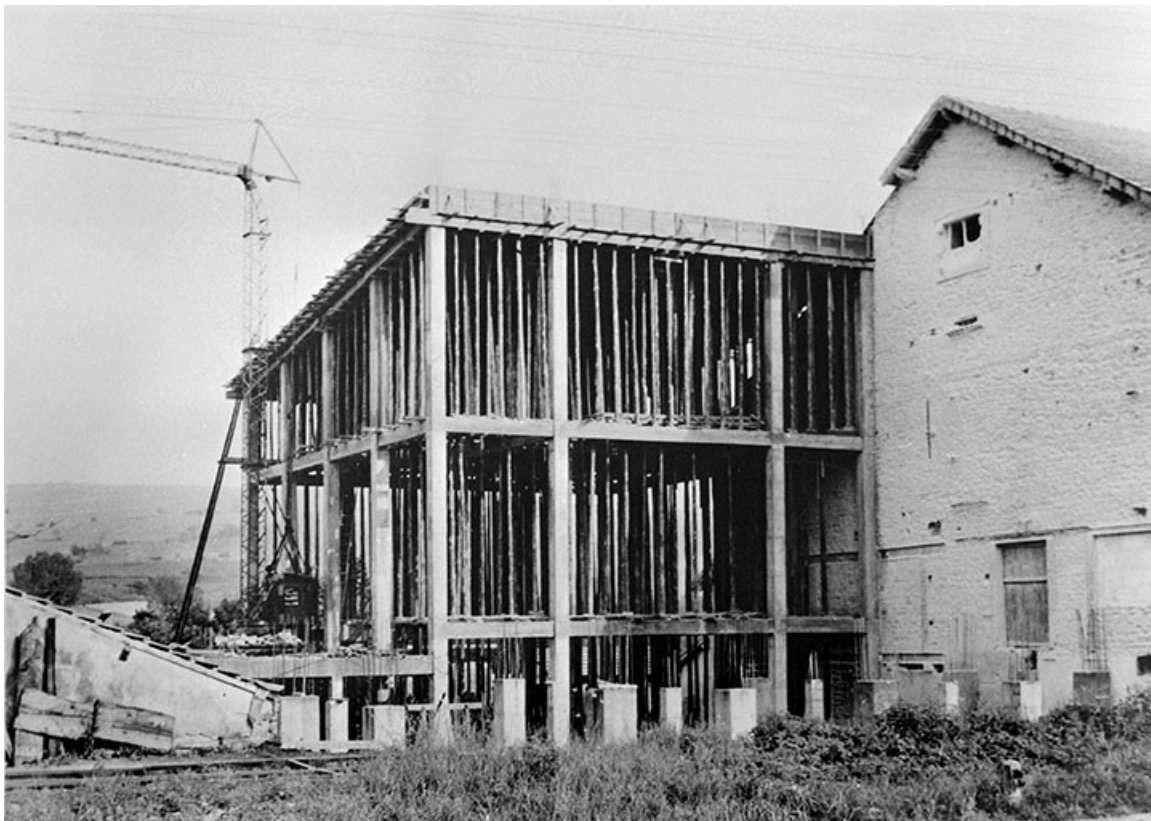
[Construction de l'atelier dit du plateau 5].
