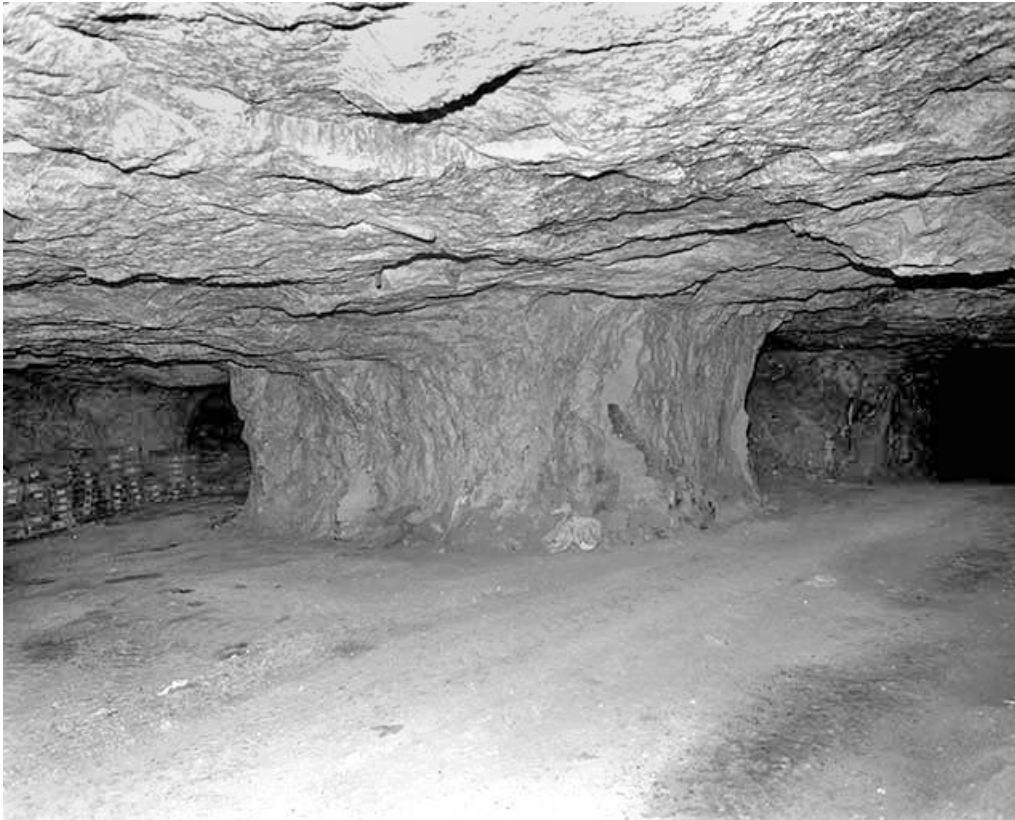
Pilier de soutènement d'une ancienne chambre d'exploitation.
