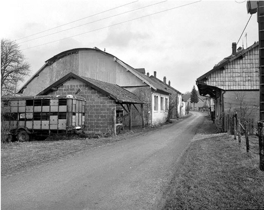
Ateliers de fabrication depuis le sud.
