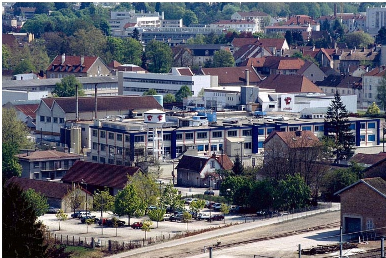
Vue d'ensemble depuis la côte de Montciel.
