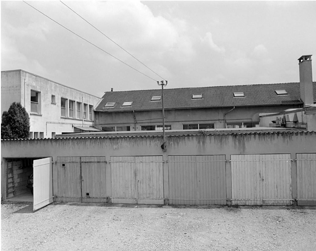
Bureau et atelier de fabrication depuis l'ouest.
