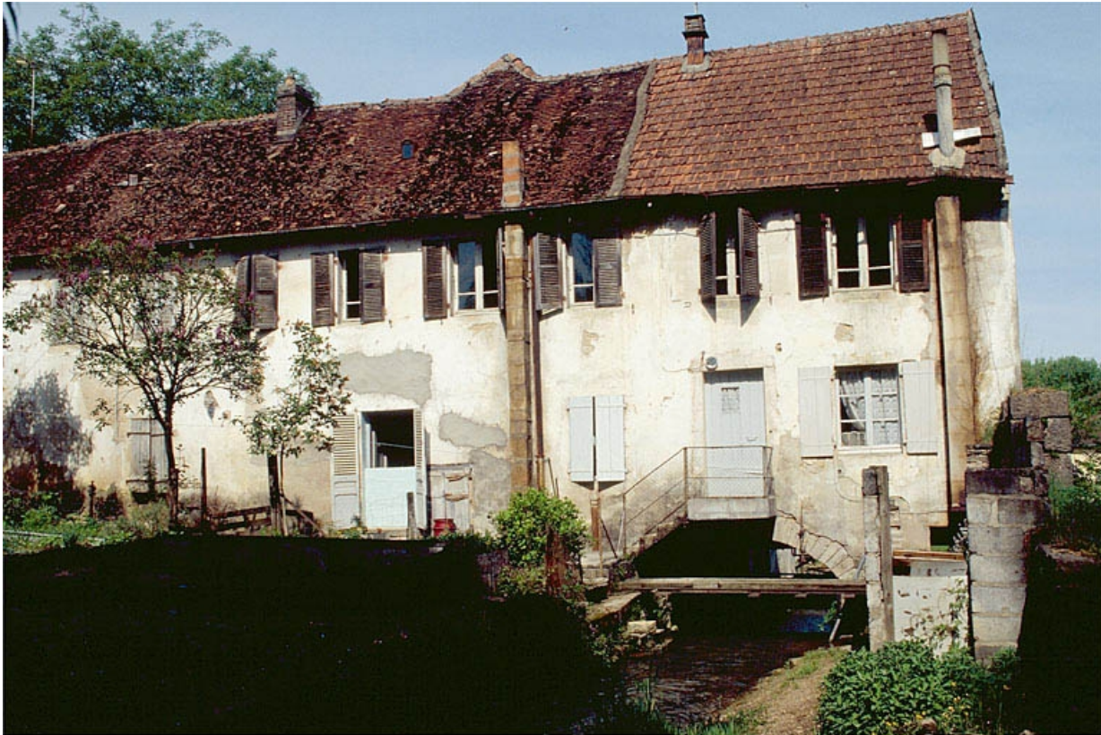
Bâtiment d'eau et logement depuis le sud-est.
