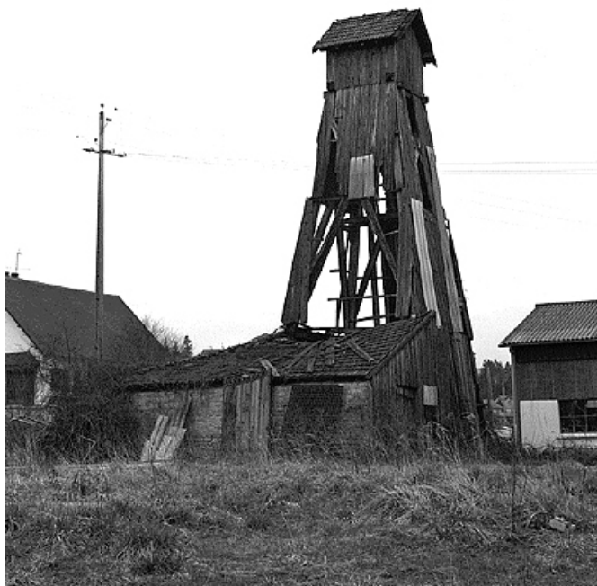
Chevalement du puits n° 10 en 1985.
