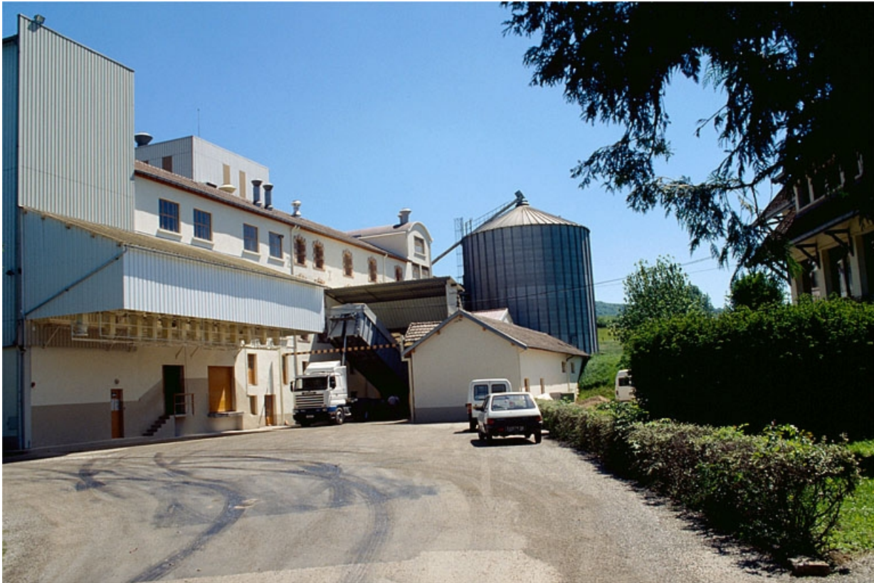
Atelier de fabrication et silos depuis l'entrée.
