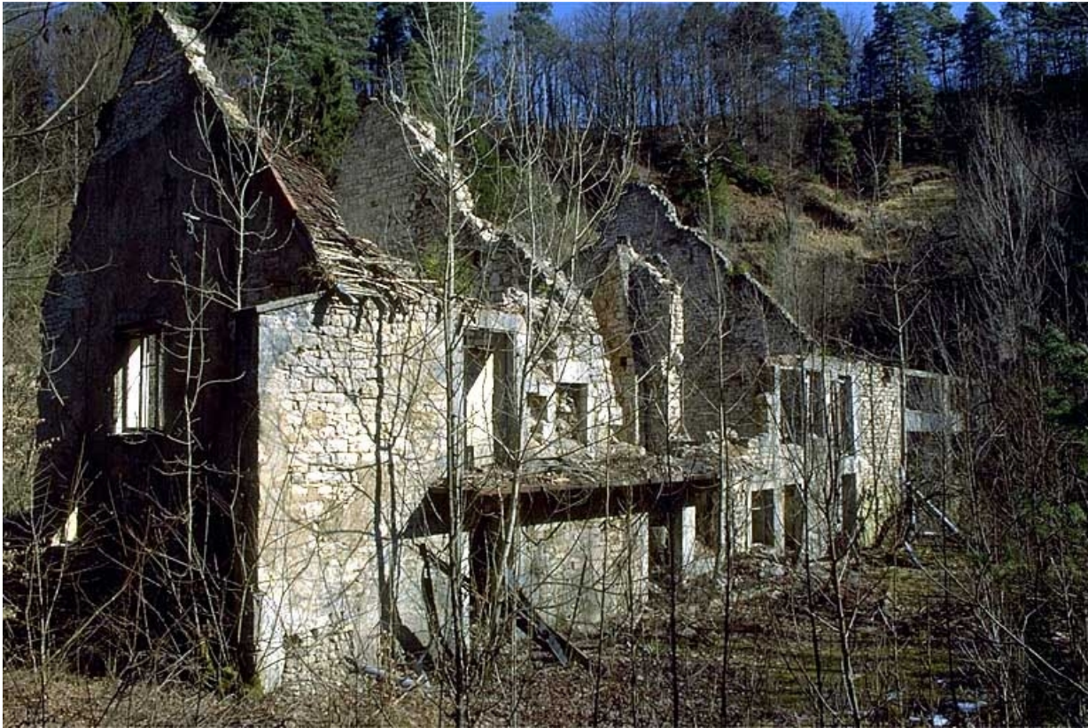
Logement patronal depuis le sud.
