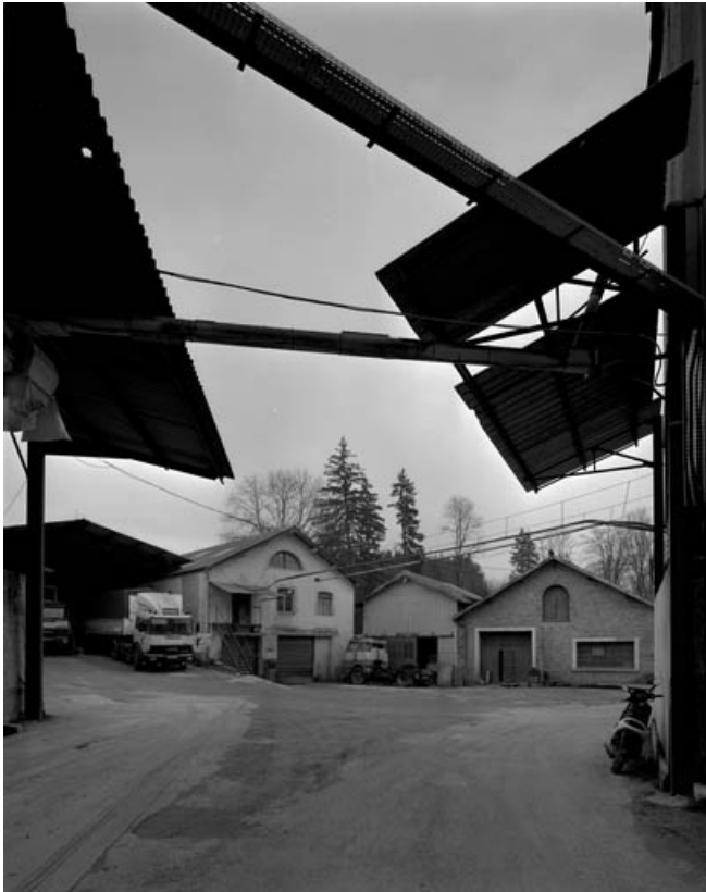
Magasins industriels et atelier de réparation.
