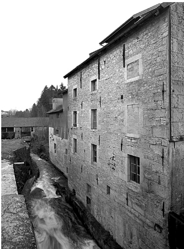
Façade sur le ruisseau de la Raillette.
