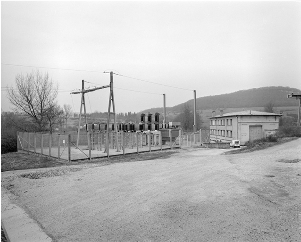
Transformateur et salle des machines.
