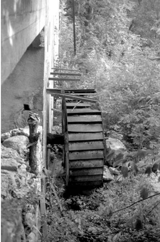
Roue hydraulique verticale amont.
