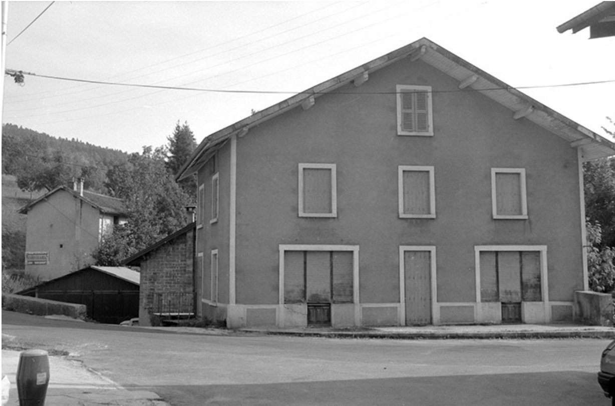
Façade antérieure du logement.
