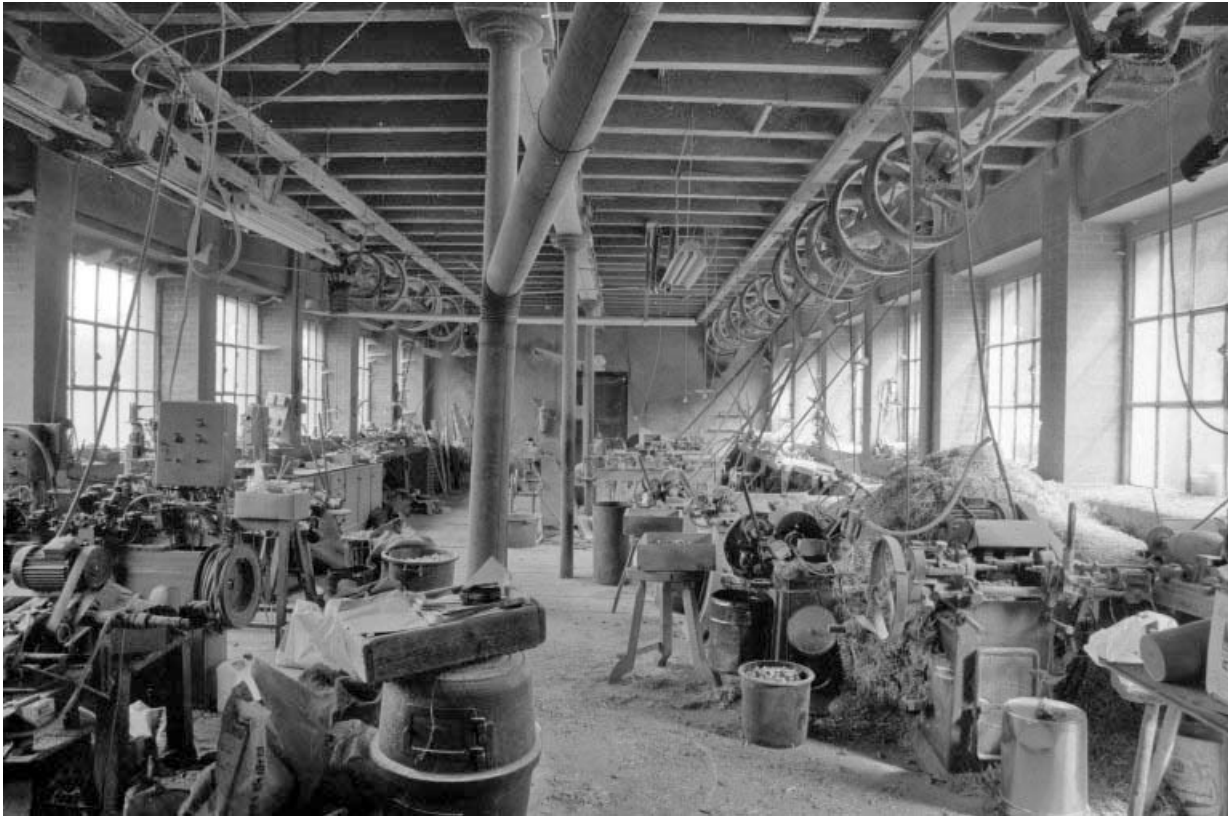
Intérieur de l'atelier de fabrication.
